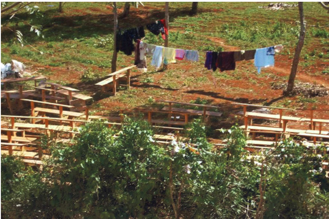
Foto 6) Banchi intatti dopo il crollo
